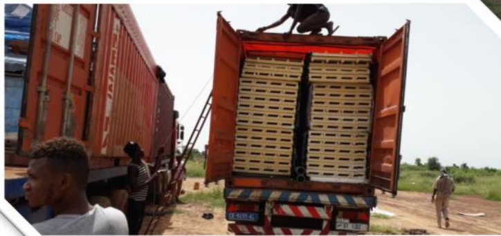
Arrivano i pannelli per i tetti
