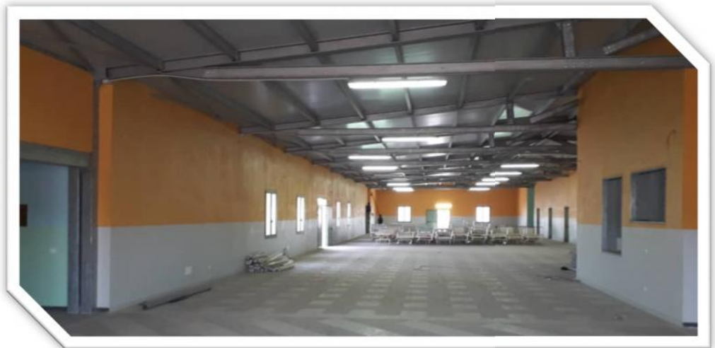
Il corpo centrale
