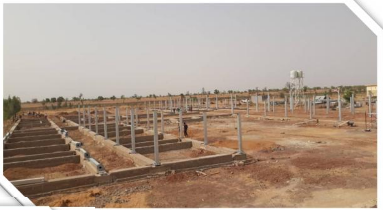
Le fondamenta e le prime colonne
