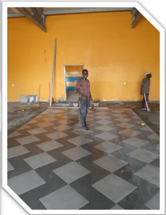
Si posano i pavimenti
