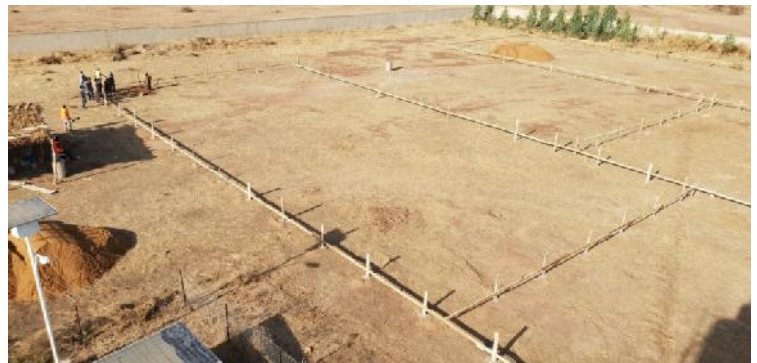
Tracciatura delle fondazioni
