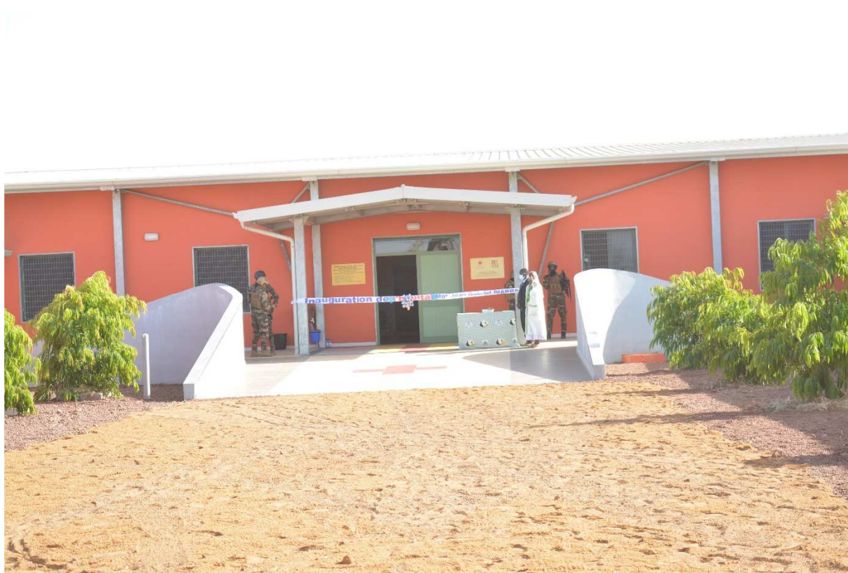
Porte d'entrée de l'hôpital Diocésain
