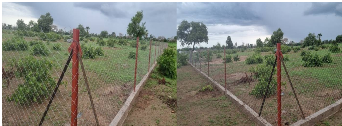
Installation du jardin de Wakoro
